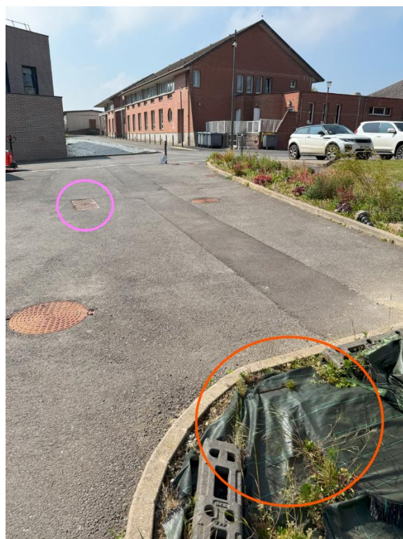
En orange : Chambre de tirage sous la bâche en limite de propriété pour raccordement concessionnaire
